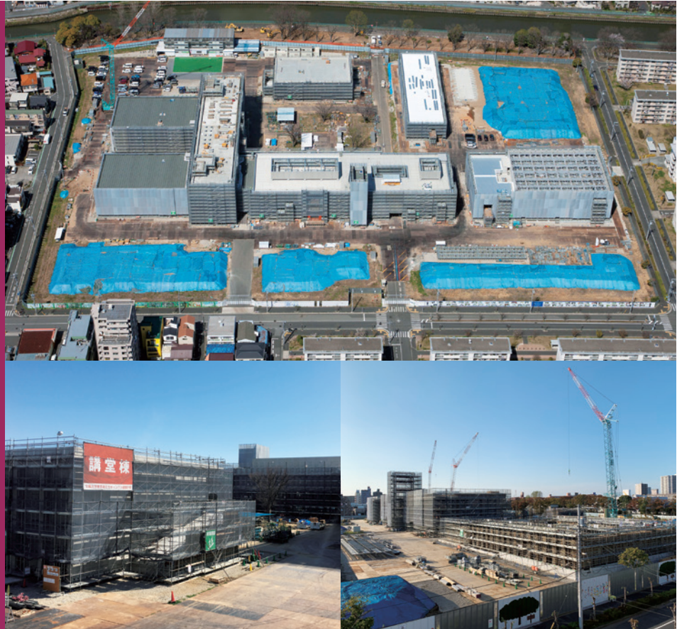
東京あだちキャンパス建築風景
